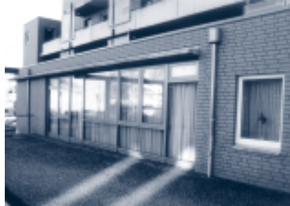
Zum Glück nicht ausgebrannt: Wohnraum der Behinderteneinrichtung am Netzeplatz.
