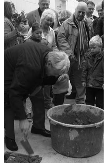
Der Grundstein wird in den Boden der Krippe eingemauert.
