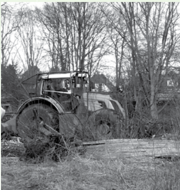
Die Bäume fallen und der Boden wird planiert.
